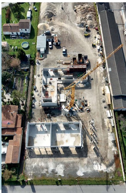
Chantier parc douelles vue drone
