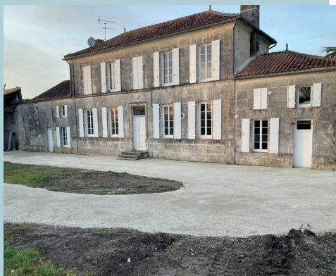
Maison des Buissons
